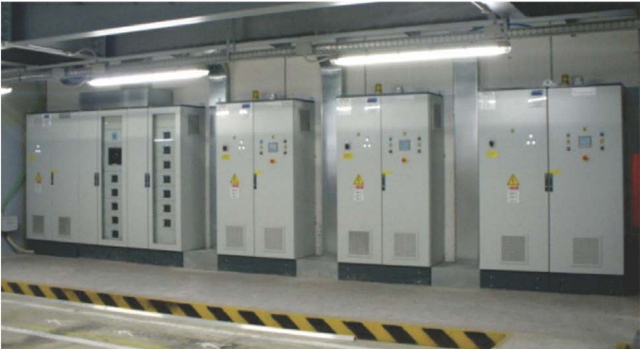
Instalado en Aeropuerto de Fiumicino NET 6000 (Roma)
