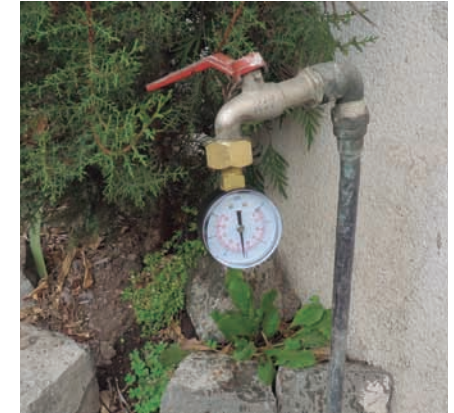
MEDICIÓN DE PRESIÓN CON MANÓMETRO
