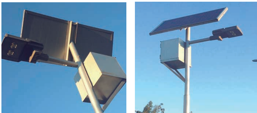
LUMINARIA SOLAR EN PARADEROS DE BUSES, COLINA
