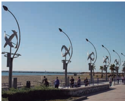
LUMINARIAS HÍBRIDAS EN MÁLAGA, ESPAÑA
