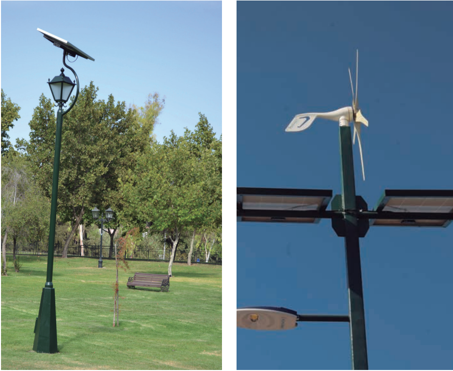
LUMINARIAS DE MEDIA ALTURA CON GENERACIÓN DE ENERGÍA IN SITU, VITACURA, SANTIAGO
