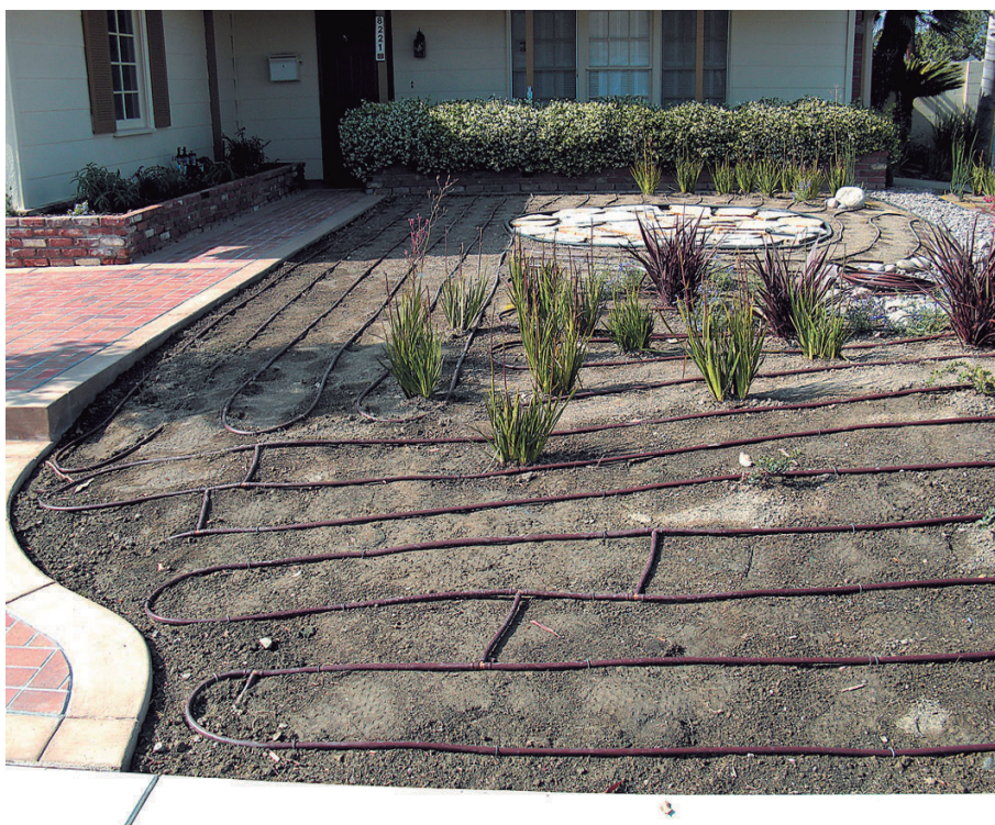
RIEGO POR GOTEO EN SUPERFICIE
