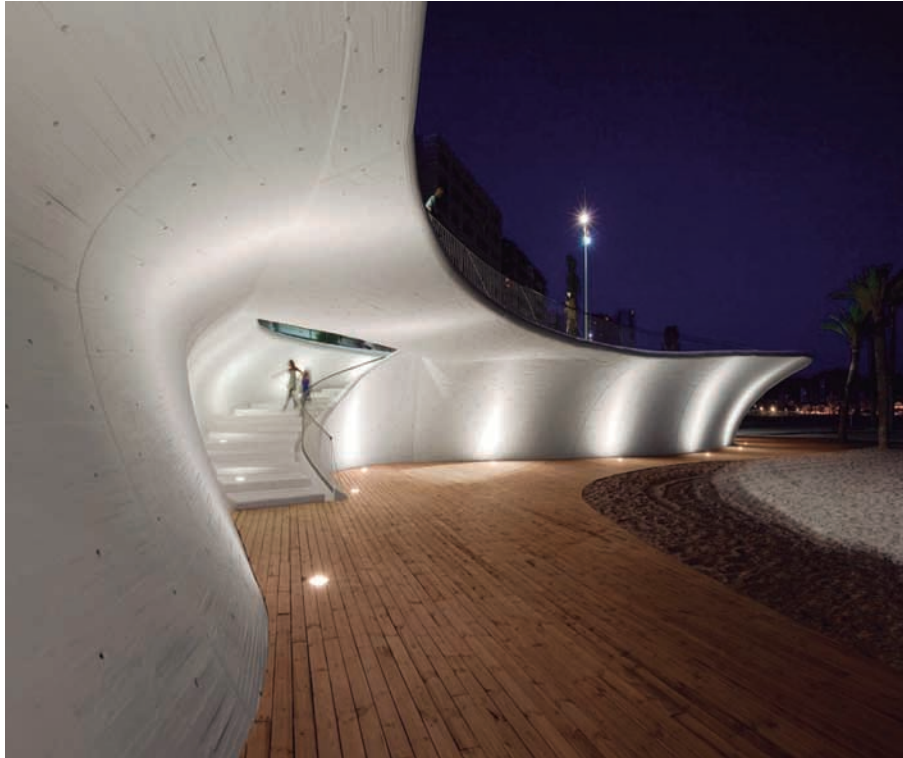
LUMINARIA UP-LIGHT EN PASEO MARÍTIMO DE BENIDORM, ESPAÑA
