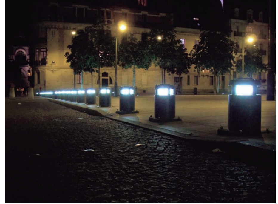
LUMINARIAS DE MEDIA ALTURA, FRANCIA
